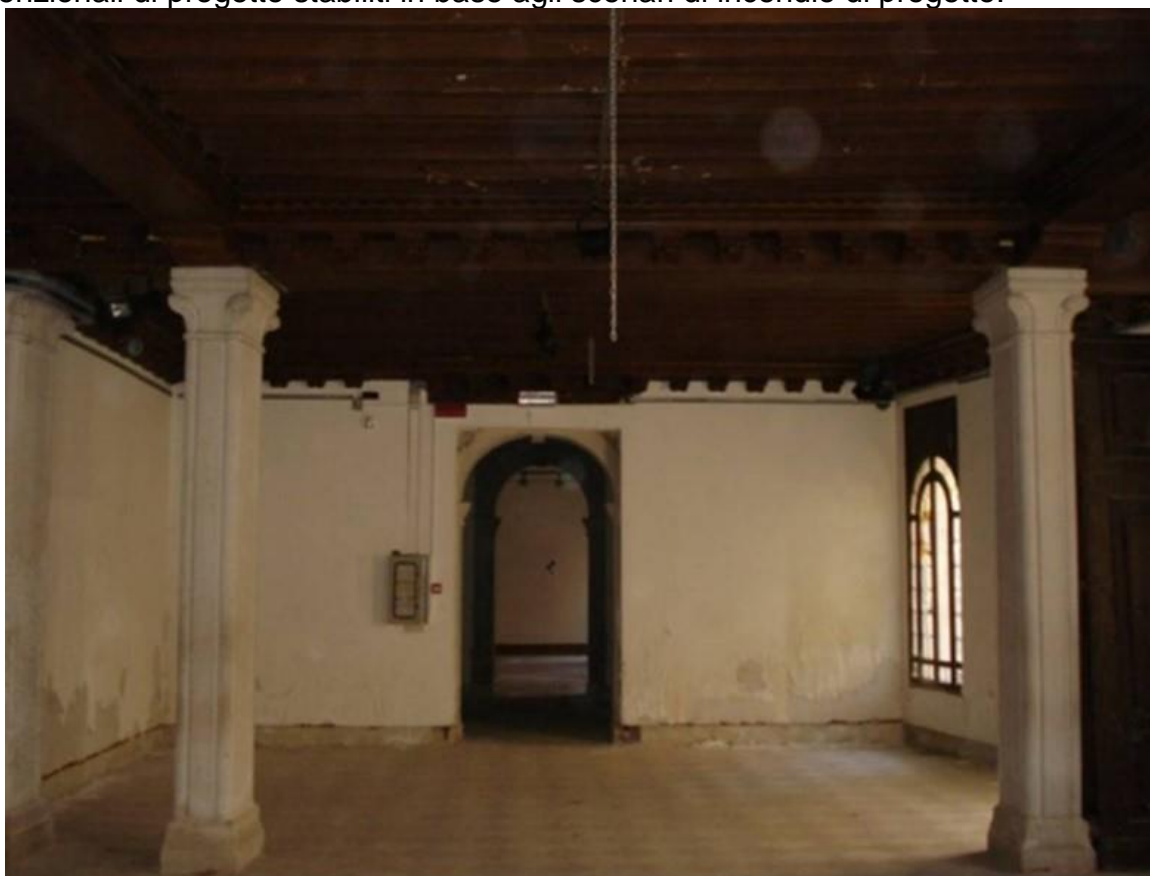
Fig.3 – Resistenza al fuoco - solaio ligneo al piano terra
