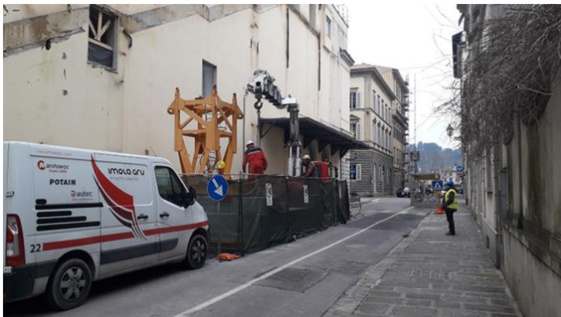
Figura 17 - Montaggio della gru a Torre su via Magenta
