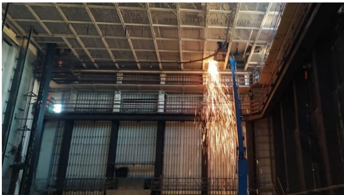
Figura 5 - Taglio degli elementi metallici in quota costituenti i camminamenti della torre scenica
