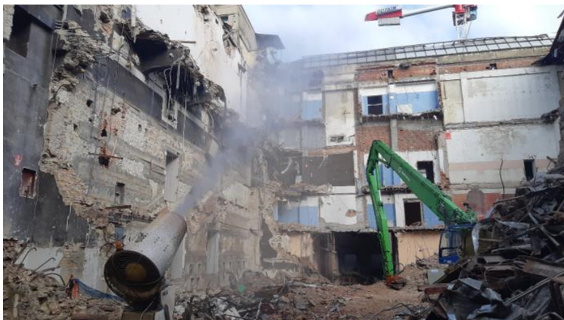
Figura 35 - Demolizione degli edifici adiacenti
