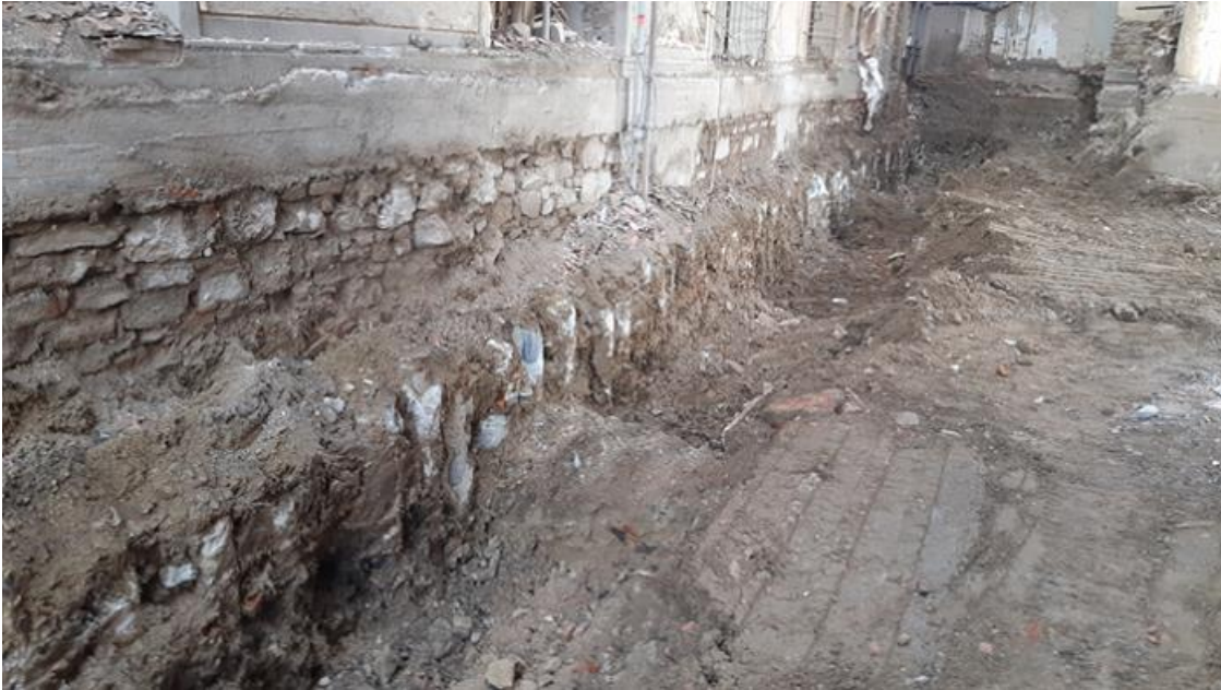
Figura 23 - Micropali nel foyer
