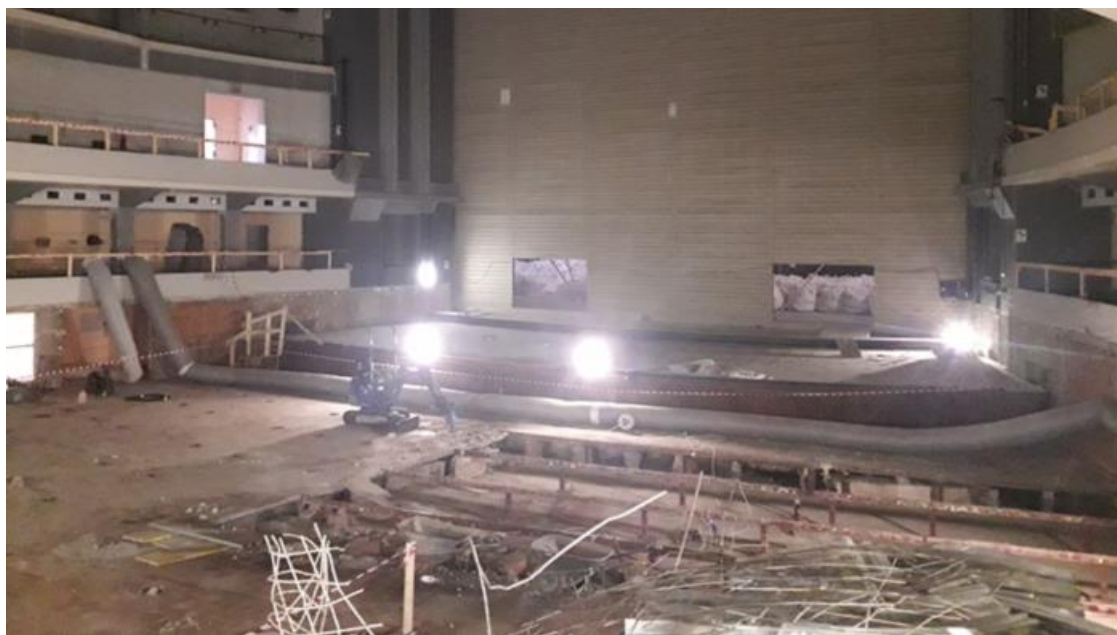
Figura 7 - Smontaggio dei solai del palcoscenico e della torre scenica
