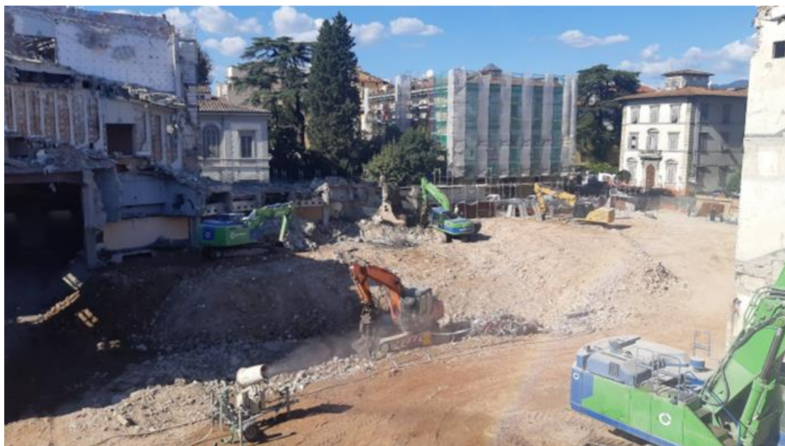
Figura 37 - Demolizione fino al piano campagna degli edifici adiacenti
