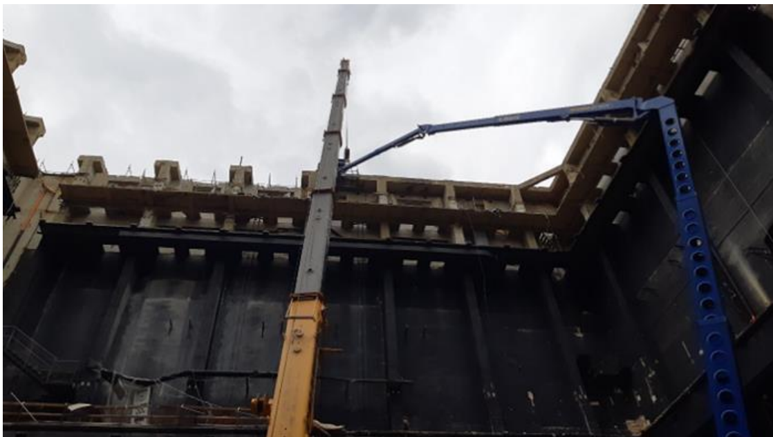
Figura 28 - Demolizione delle murature laterali della torre scenica
