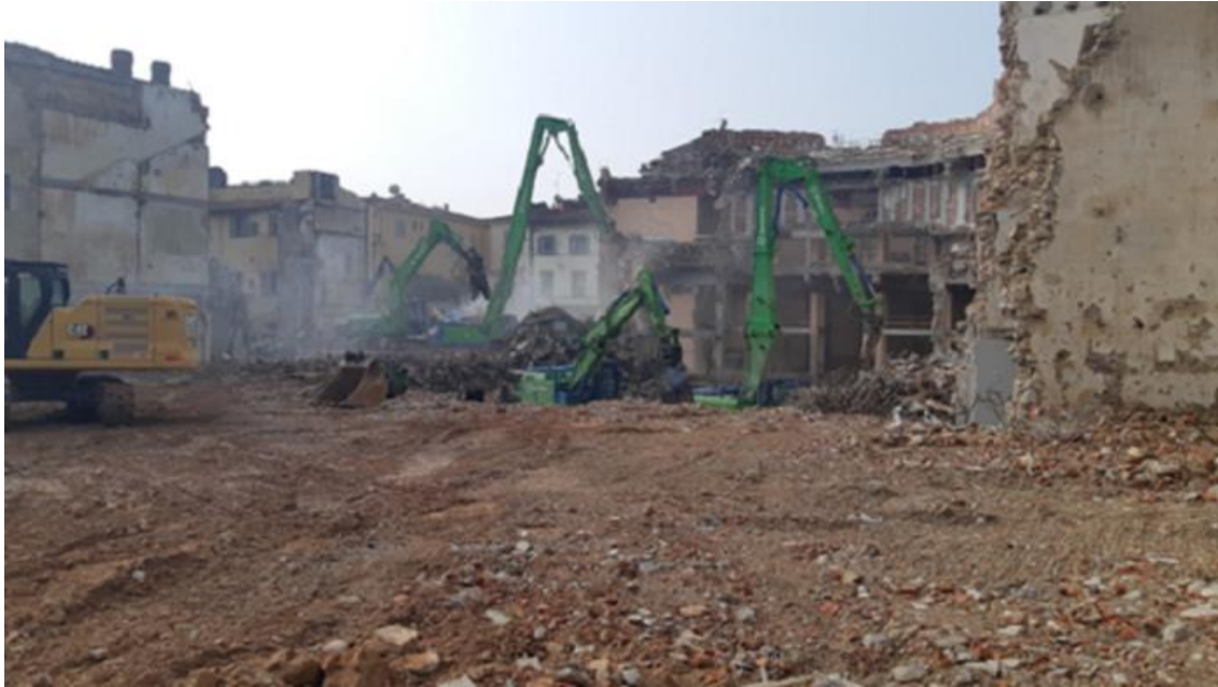
Figura 32 - Demolizione delle murature del Teatro fino al piano campagna
