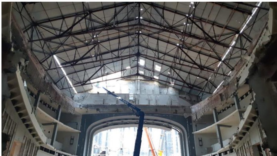
Figura 26 - Rimozione del manto di copertura del Teatro
