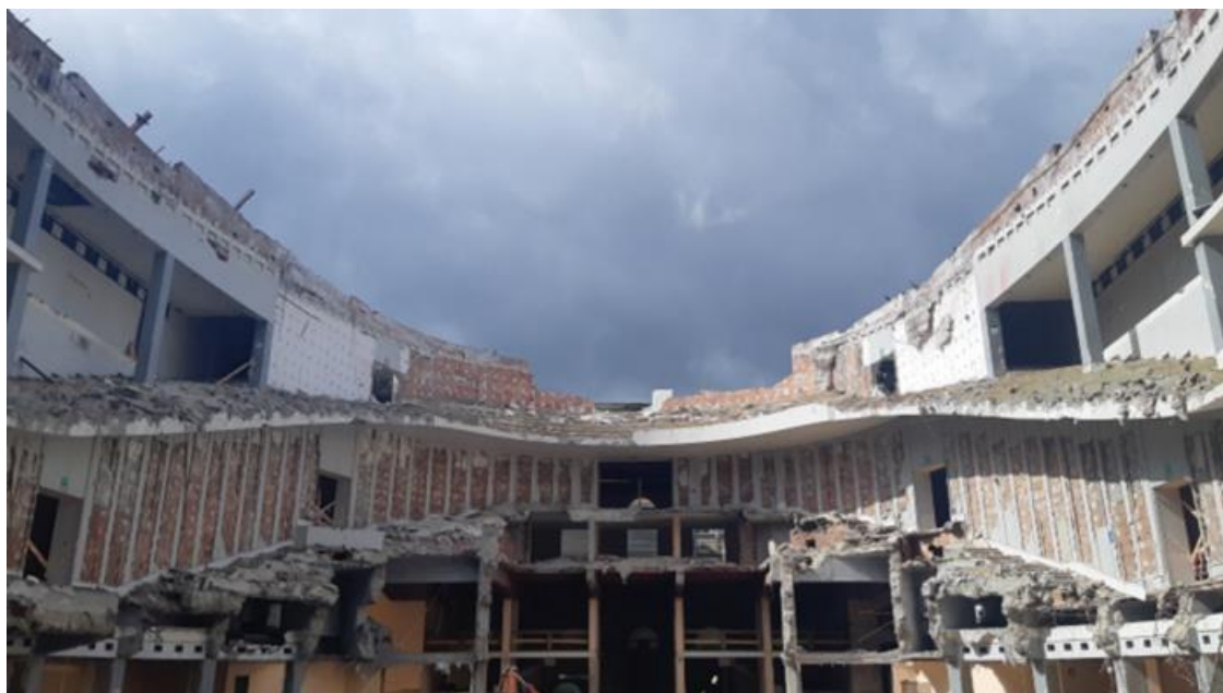
Figura 30 - Demolizione delle murature del Teatro al livello delle gallerie
