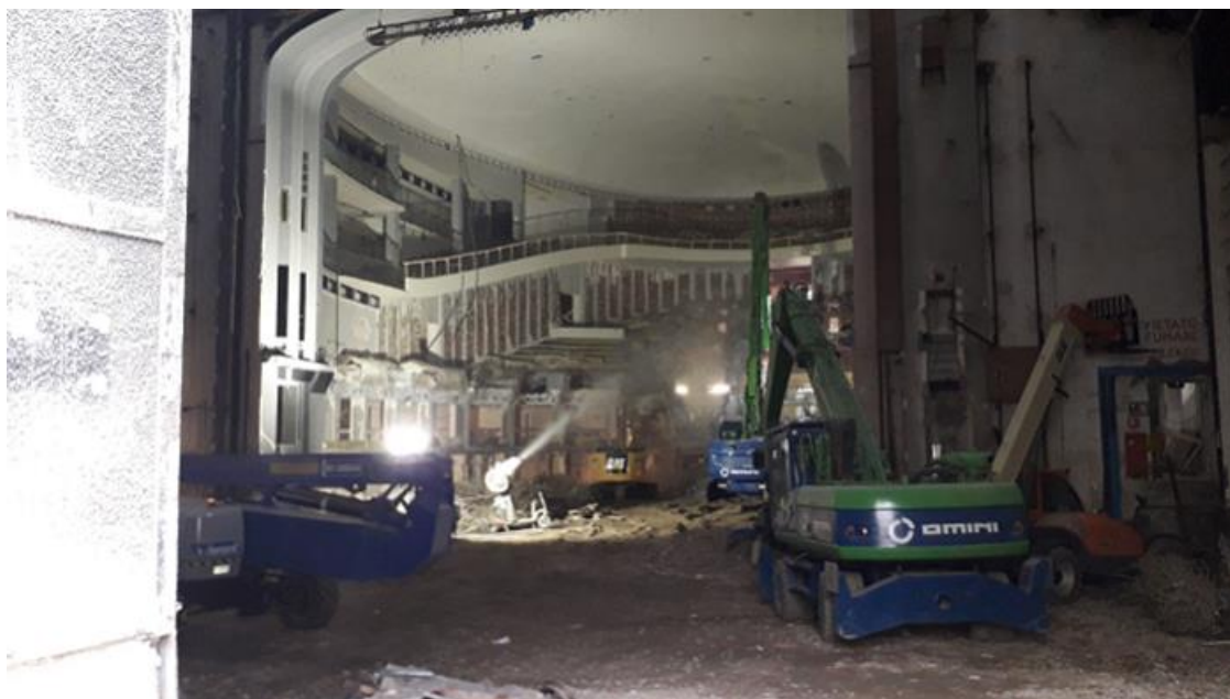
Figura 13 - Demolizione delle gallerie del Teatro
