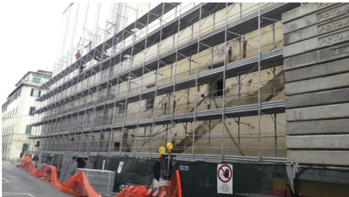
Figura 15 - Installazione del ponteggio su via Magenta
