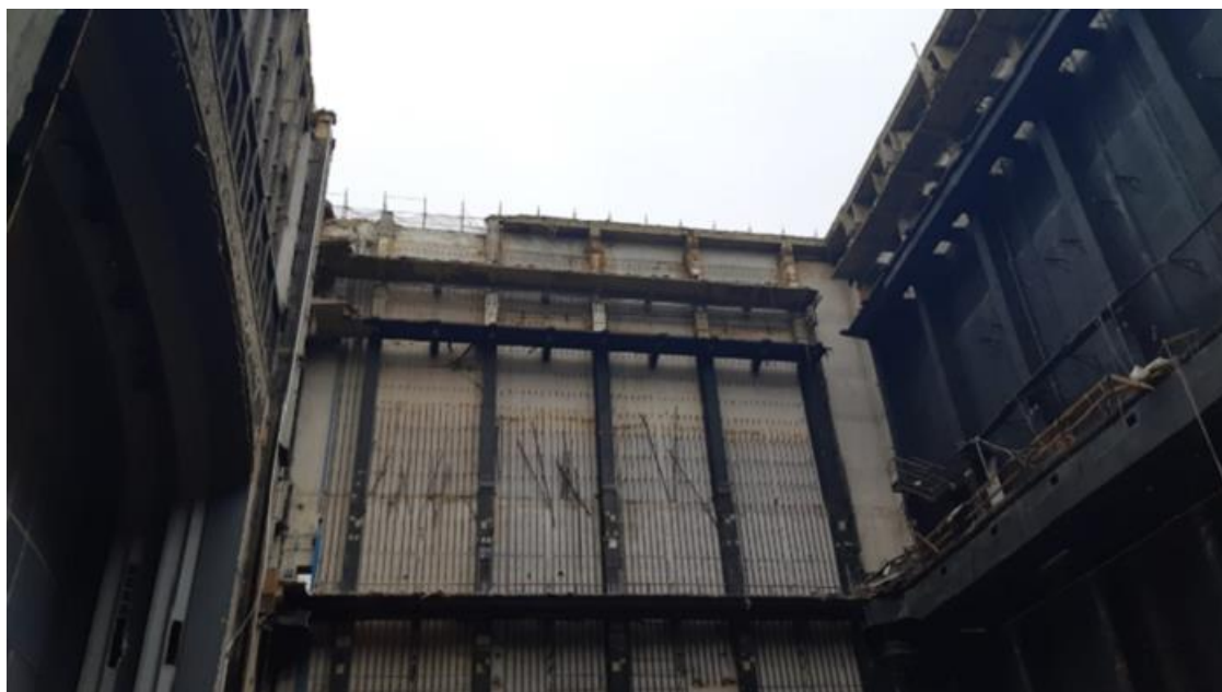
Figura 21 - Smontaggio della struttura portante della copertura della torre scenica
