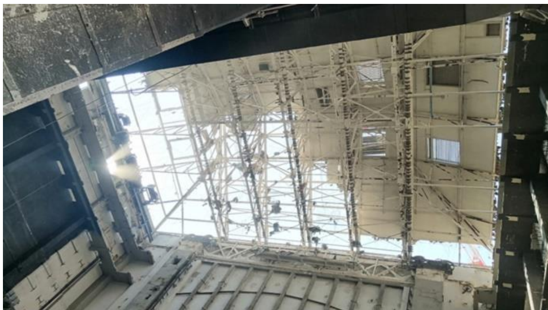
Figura 19 - Rimozione del manto di copertura della torre scenica
