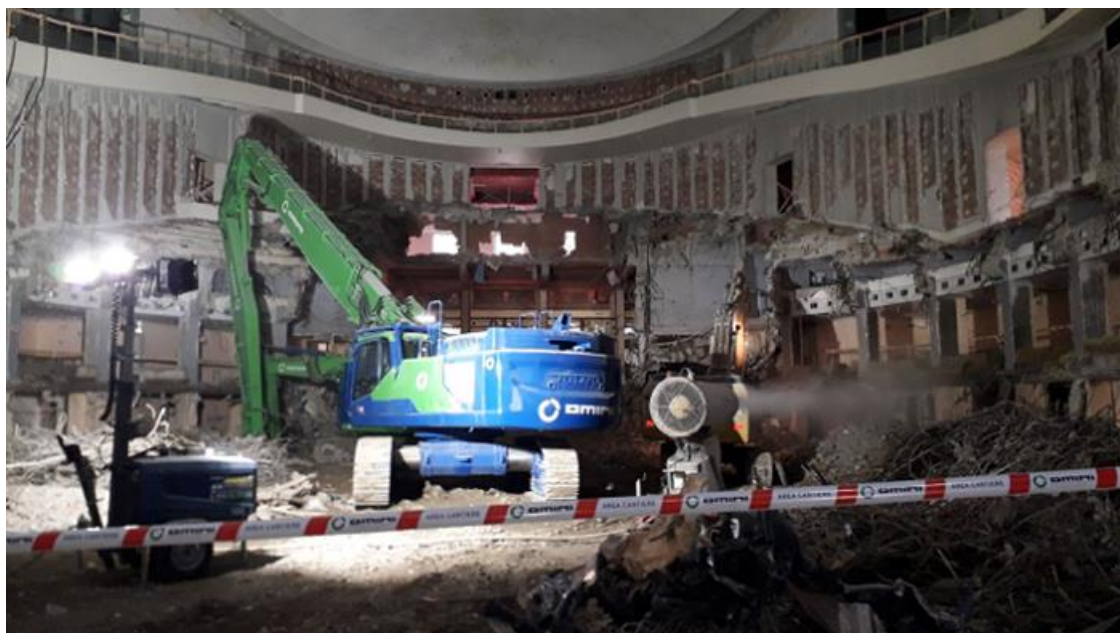
Figura 11 - Demolizione meccanica della platea e del primo anello del Teatro
