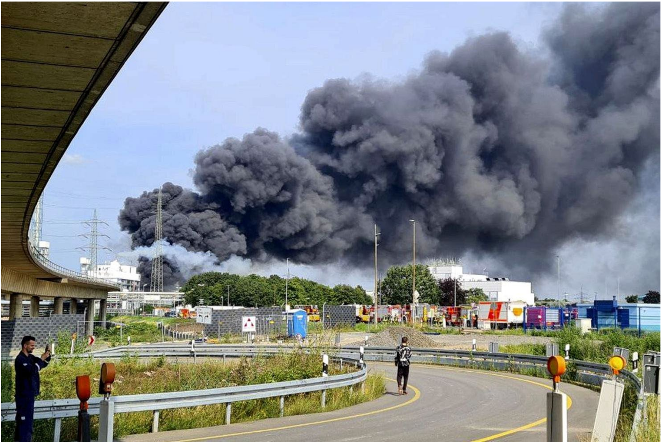
Figura 3. Incendio in un inceneritore di rifiuti pericolosi a Leverkusen, Germania, 27 Luglio, 2022. Fonte: The Times
