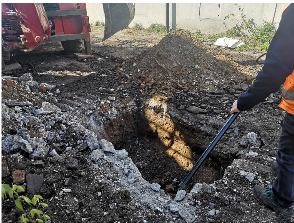
Figura 4 - Scavo a sezione ristretta per scoprimento di anomalia ferromagnetica
